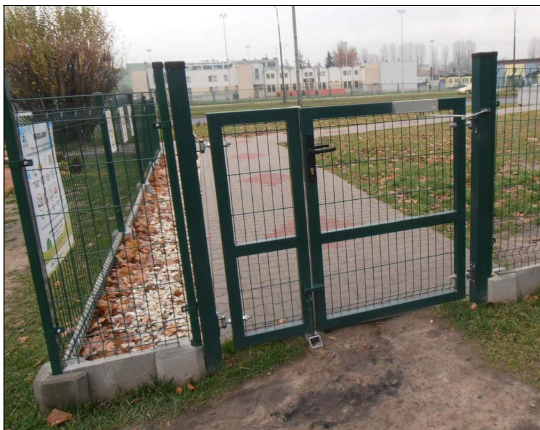
Fot.3 Projektowana furtka dwuskrzydłowa. Po prawej stronie widoczny samozamykacz.
